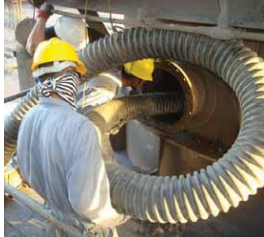
إزالة مخلفات الكشط بواسطة الشفط في مصنع الاختزال المباشر-١ (مايو ٢٠٠٩)
